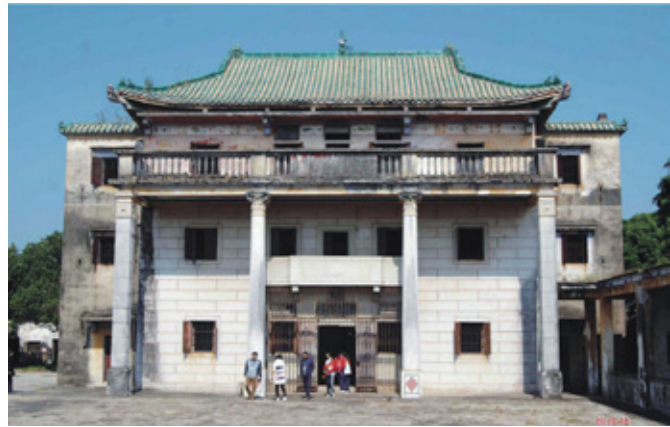
侨宅炯成楼雄伟外景
